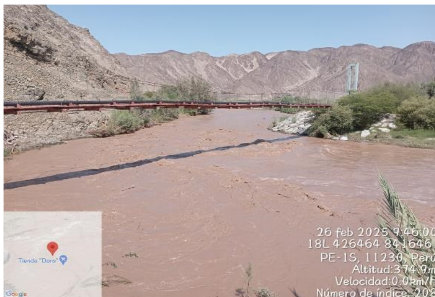
FIGURA N°03: EN LA TEMPORADA DE MAXIMAS AVENIDAS, EL RÍO ICA SOCABA ESTE TRAMO DEL SECTOR LA COLMENA, ARRASANDO CON LA VIA DE ACCESO AL LUGAR.
